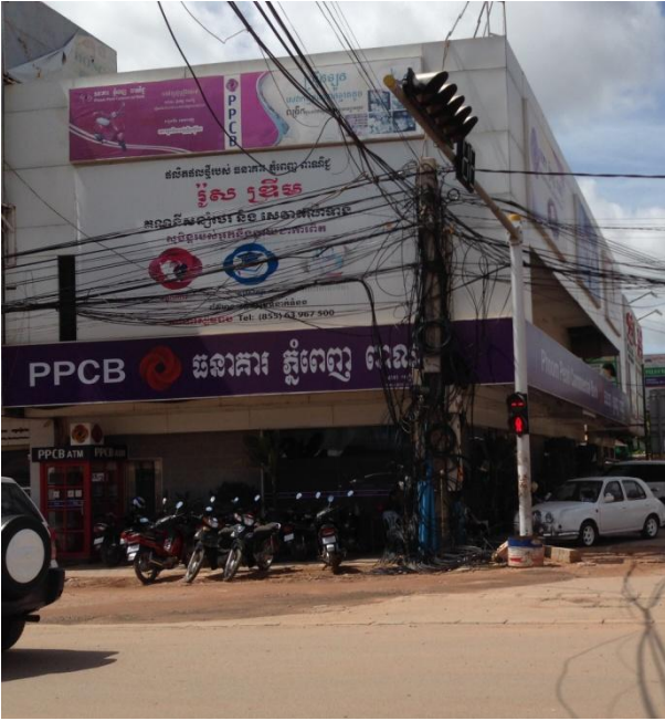
Sieć energetyczna level Azja, Siem Reap, Kambodża
